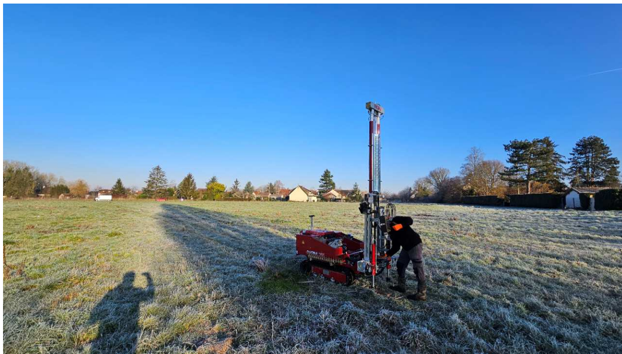
Photographie des sondages en cours en janvier 2025
