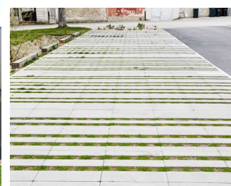
Parking perméable en béton
