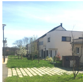
Dalles béton joints Enherbés
