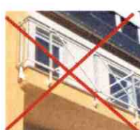
Garde-corps à croisillons
