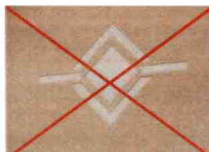
Motifs sur façade non autorisés
